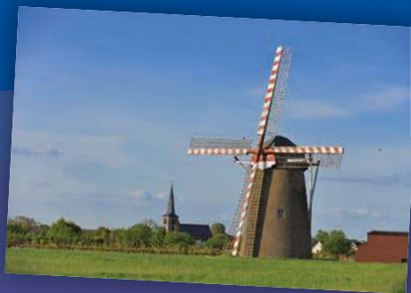
Die Turmwindmühle („Erdholländer“) aus dem Jahr 1897 wird heute noch als Getreidemühle betrieben.
